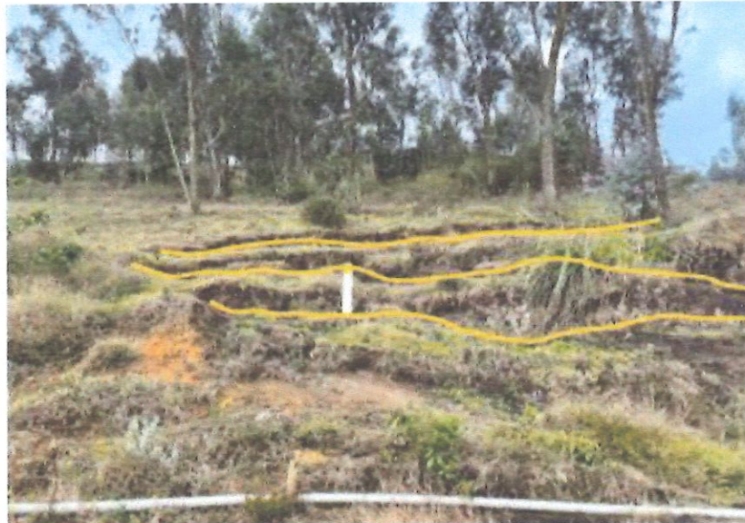
Gráfico N° 20: Zonas de escarpas que demuestran el desplazamiento del suelo en la zona de Carniche.
