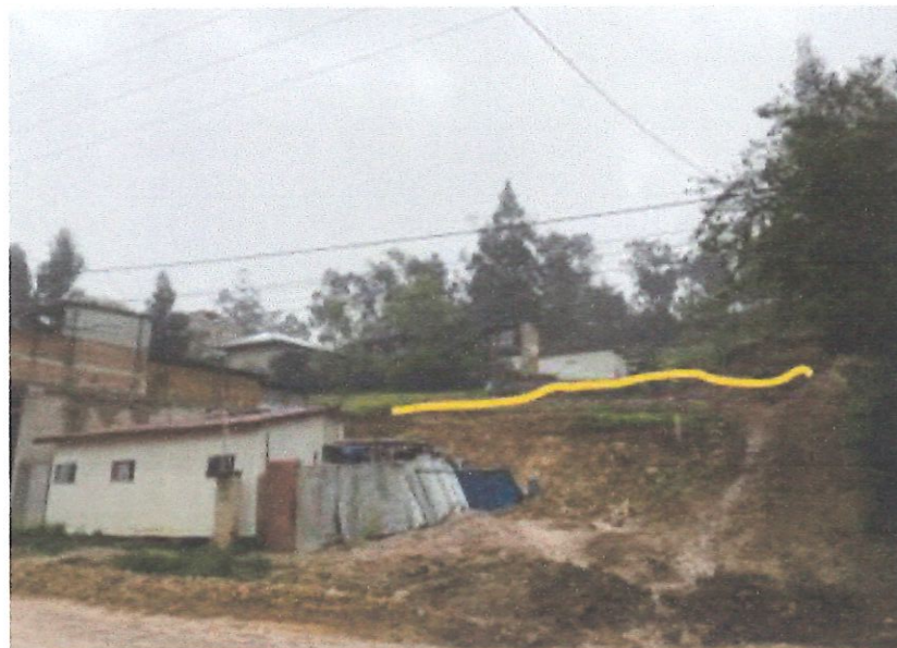
Gráfico N° 21: Movimientos lentos desplazan el suelo en Carniche, lo que demuestra la actividad de desplazamiento de suelo.
