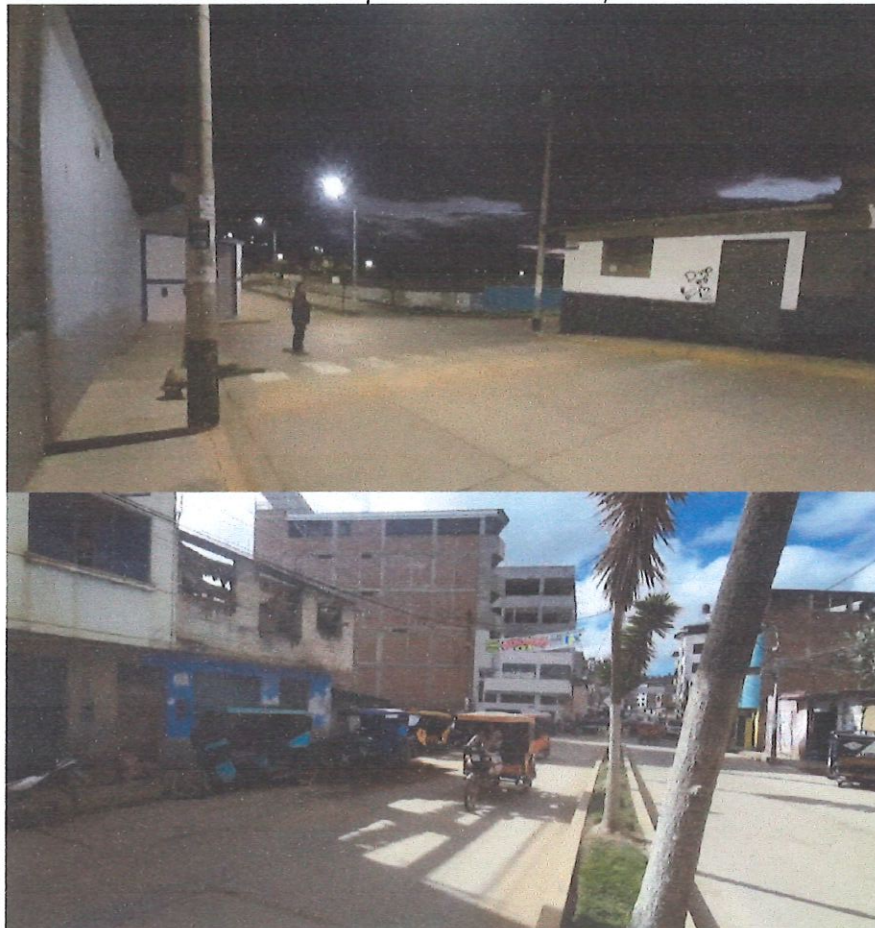
Gráfico N° 135: Marcas en el pavimento deficiente, Altura Estadía Cutervo
