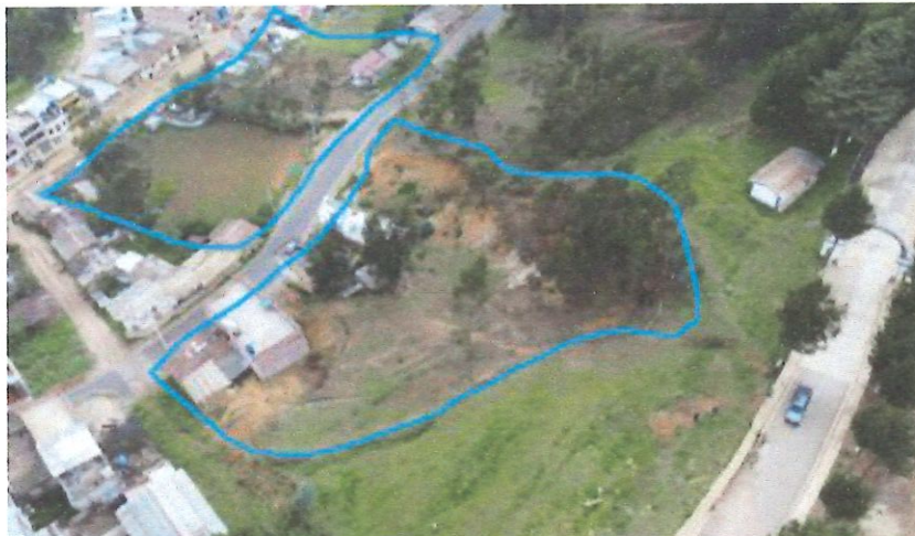
Gráfico N° 22: Vista aérea de la zona de reptación de suelo en el Barrio de Carniche.
