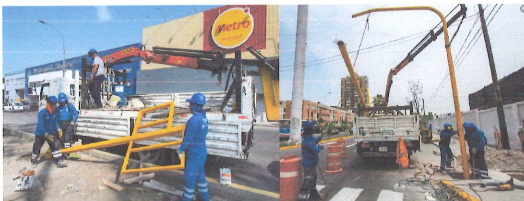
Gráfico N° 10: Instalación de dispositivos semafóricos
