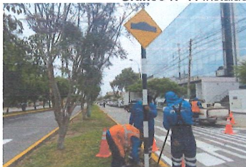
Gráfico N° 7: Instalación de señalización vertical
